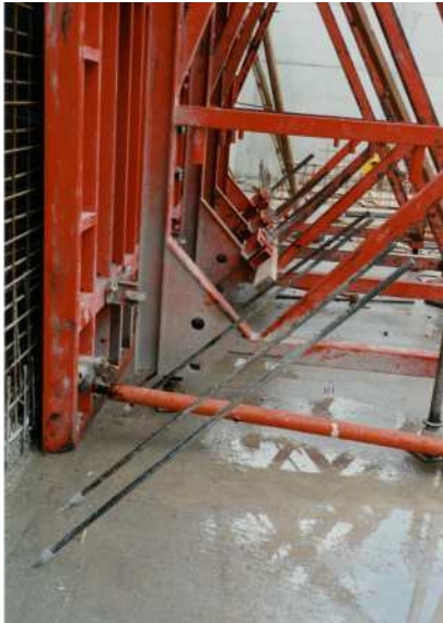
Stützböcke PERI Rückverankerung in korrekter 45°-Lage
