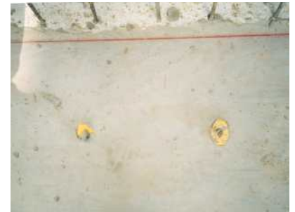
Verwendung in Bodenplatten ohne Behinderung von Abziehlplatte oder Flügelglätter stufenlos teleskopierbar für Betonüberdeckung 30 - 60 mm
